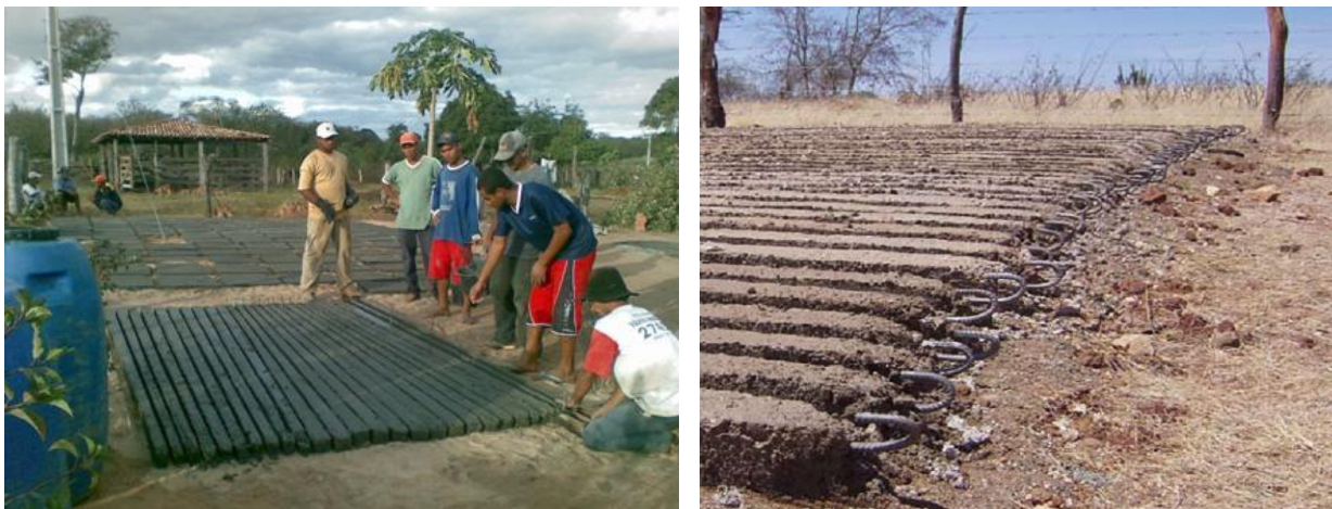
Figura 8: Confecção dos caibros da cobertura da cisterna
