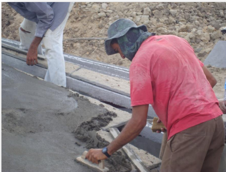
Figura 15: Colocação das placas de cobertura
