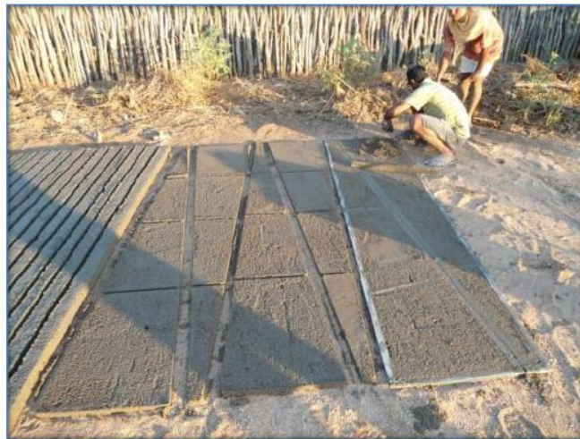
Figura 7: Fôrma das 4 diferentes placas da cobertura da cisterna
