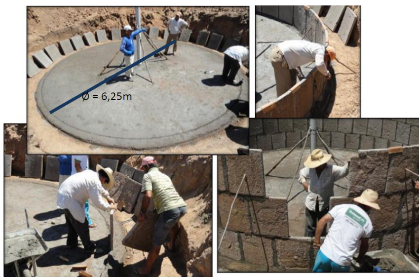
Figura 10: Construção da parede da cisterna
