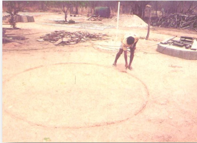
Figura 3: Marcação da área da cisterna
