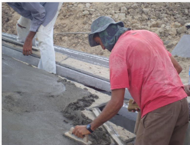
Figura 15: Colocação das placas de cobertura
