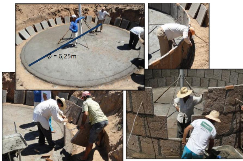
Figura 10: Construção da parede da cisterna
